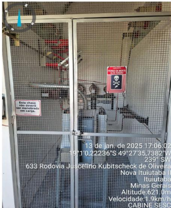
Foto 3 - Vista frontal do disjuntor de média tensão
