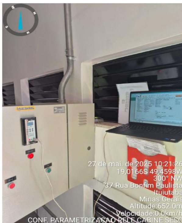
Foto 4 - Conferência e parametrização do relé de proteção
