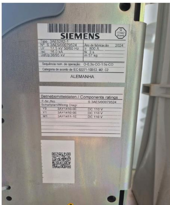
Foto 7 - Dados técnicos do disjuntor Sion 800a Siemens
